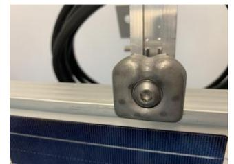
5. Die 4 Dachhaken (2 pro Schiene) mittels der mitgelieferten Befestigung in die Schiene schieben und festziehen.
